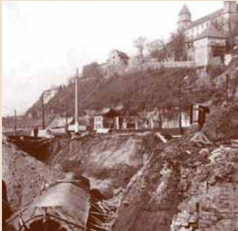
výstavba kanalizačného zberača A-II (Pri starom pivovare) r. 1970
