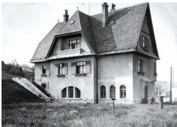
Čerpacia stanica na Mudroňovej ulici
