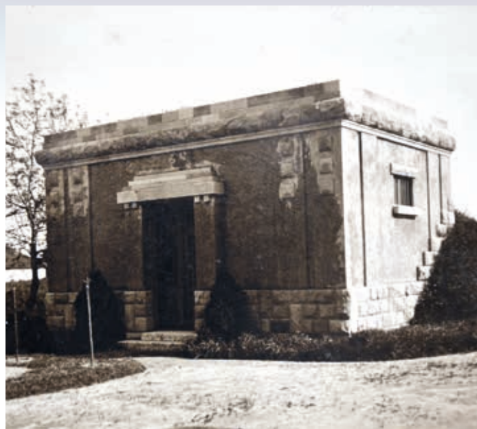
Vodojem na Mudroňovej ulici (3 000 m 3 )
